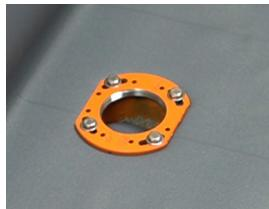
Cuando la capa de mortero este seca, realice la impermeabilización necesaria (Forro del PVC, cobre, panal de vidrio) según el código local. Asegura que la capa de impermeabilización alcance al borde del agujero en el drenaje. Vuelva a colocar la placa de sujeción de arriba al drenaje sobre las capas de impermeabilización usando tornillos.
